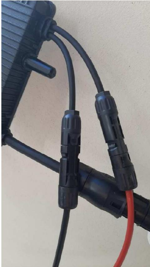
*Figura 2 Collegamento del cavo positivo e negativo derivanti dai due moduli fotovoltaici al microinverter.*
