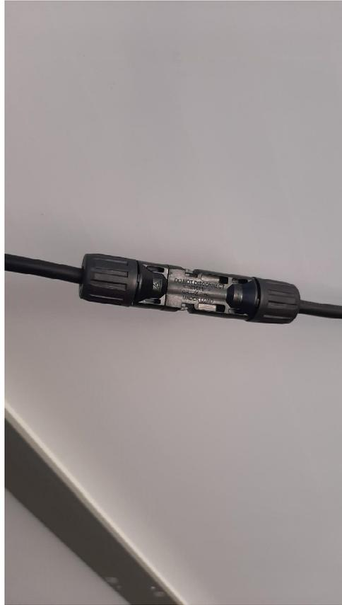
Figura 1 Collegamento elettrico in serie tra il primo ed il secondo modulo fotovoltaico
